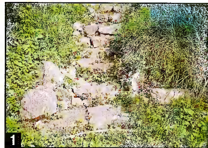
1 Ступени шириной 70 см и глубиной проступи — 40 см собраны из двух-трех камней.
