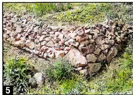
Угол формирует большой камень в виде треугольной пирамиды.
